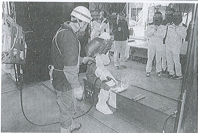
溶接作業を実践
